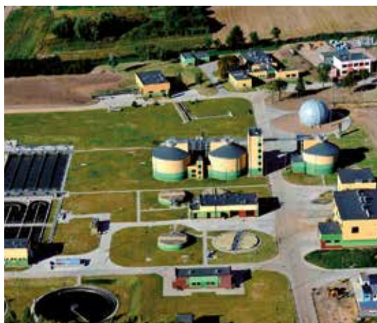
Miejska Oczyszczalnia Ścieków w miejscowości Maszewo eksploatowana przez Wodociągi Płockie Sp. z o.o.
