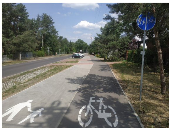
Ulica Sierakowska. Lokalizacja drogi dla rowerów po zewnętrznej stronie pasa drogowego jest niebezpieczna dla rowerzystów ze względu na ograniczoną widoczność pojazdów wyjeżdżających z posesji.
