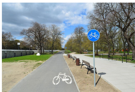
Wydzielona droga dla rowerów poza układem drogowym. Fot. Warszawa ul. Solec 38
