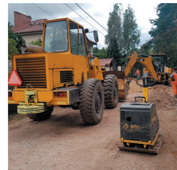
Budowa sieci kanalizacji sanitarnej w ulicy Sosnowej
