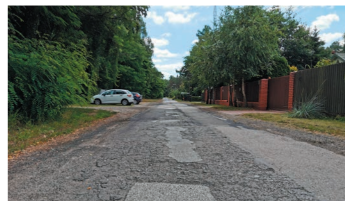
Ulica Partyzantów - przed remontem
