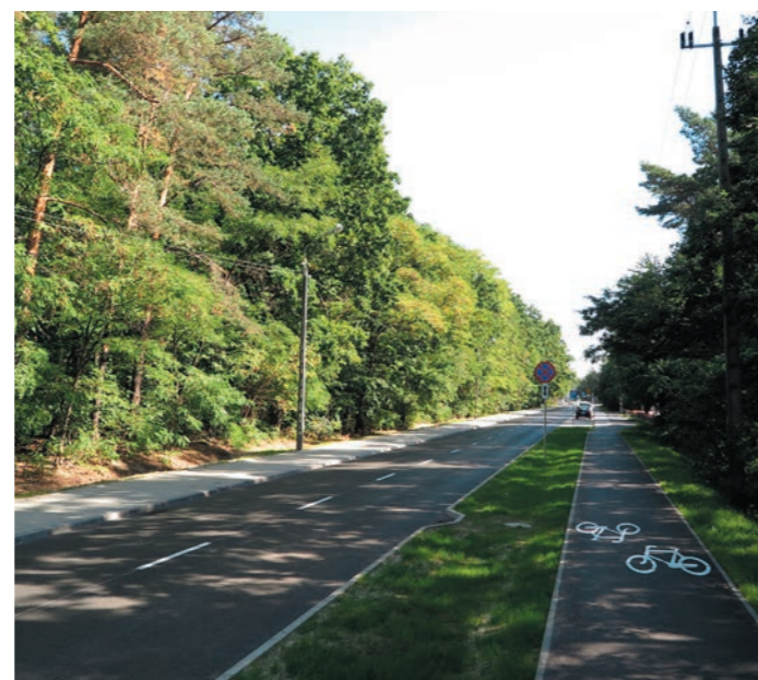
Ulica 3 Maja po remoncie
