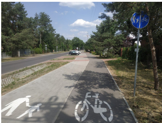
Rys. 30 Ulica Sierakowska. Lokalizacja drogi dla rowerów po zewnętrznej stronie pasa drogowego jest niebezpieczna dla rowerzystów ze względu na ograniczoną widoczność pojazdów wyjeżdżających z posesji.
