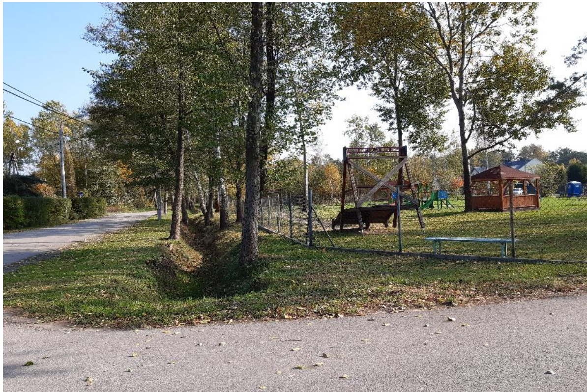
Rycina 111. Zbiorniki i rowy infiltracyjne w ul. Rynkowej. Fot. własna
