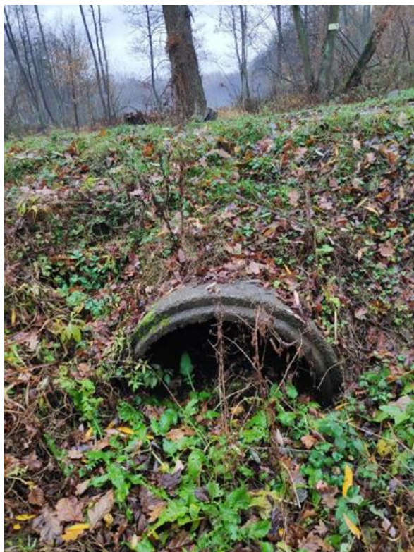
Rycina 114. Wybrane przypadki przepustów drogowych niedrożnych (rejon Truskawia). Fot. własna
