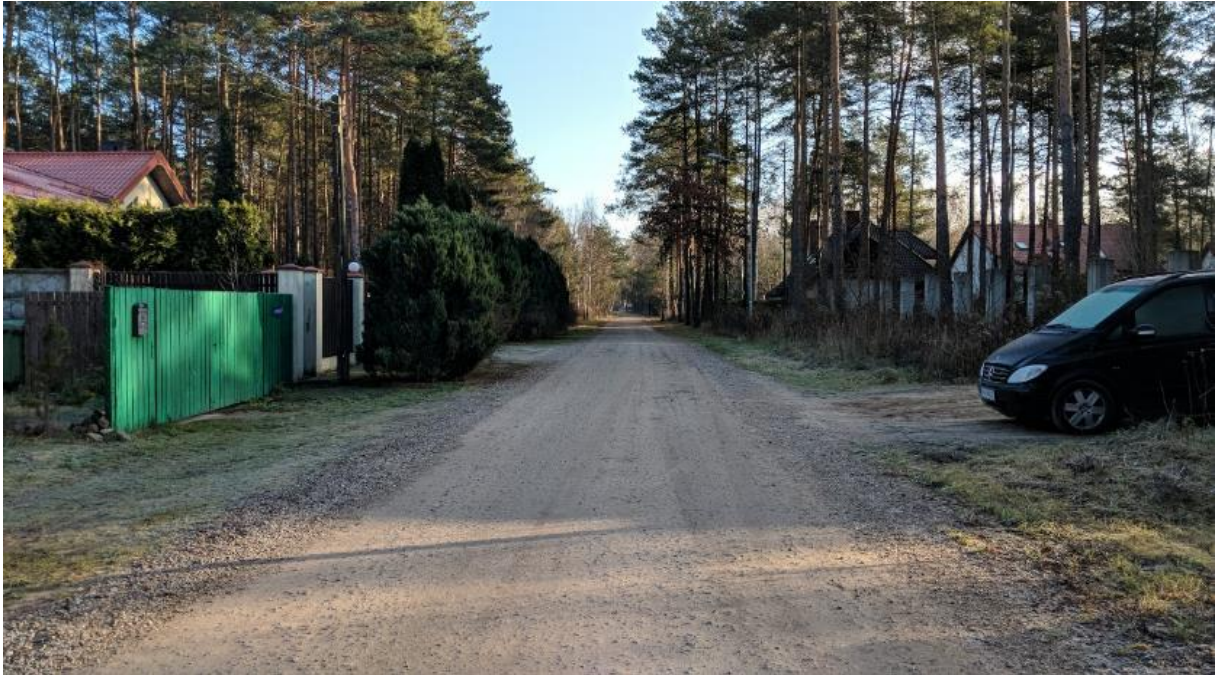
Rycina 87. Przykład Droga utwardzona, możliwe częściowe wsiąkanie w pasie jezdni lub w pasie jezdni i na poboczu. Fot. własna
