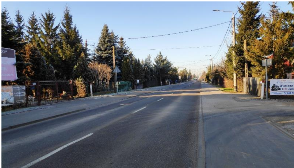
Rycina 85. Przykład drogi uszczelnionej, niemożliwe wsiąkanie - ul. 3 Maja, Mościska. Fot. własna
