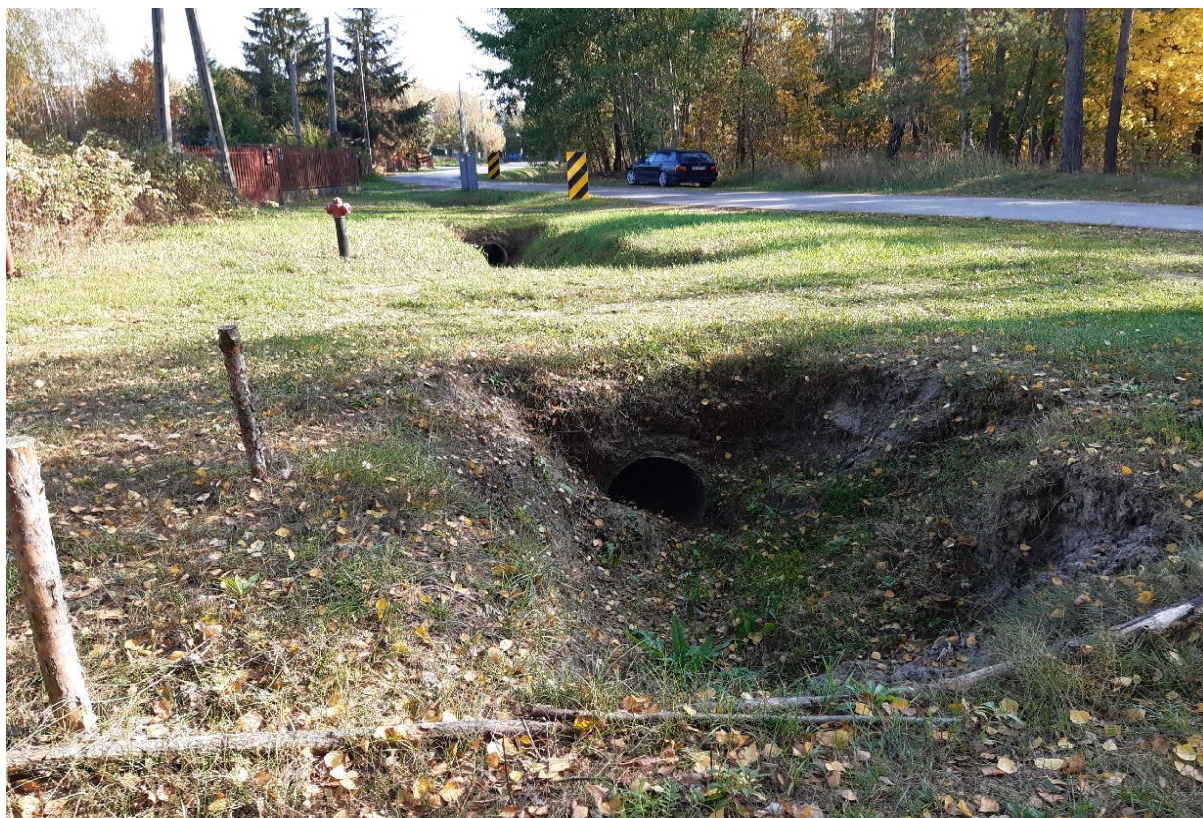
Rycina 110. Przepusty drogowe w rejonie ul. Ptańskiego. Fot. własna
