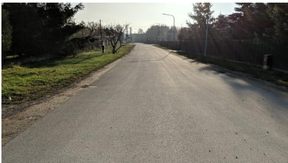
Rycina 86. Przykład droga uszczelniona, możliwe wsiąkanie na poboczu. Fot. własna
