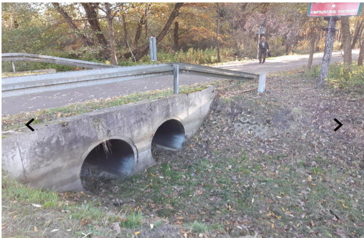
Rycina 108. Przepusty drogowe w rejonie ul. Ptaśńskiego. Fot. własna
