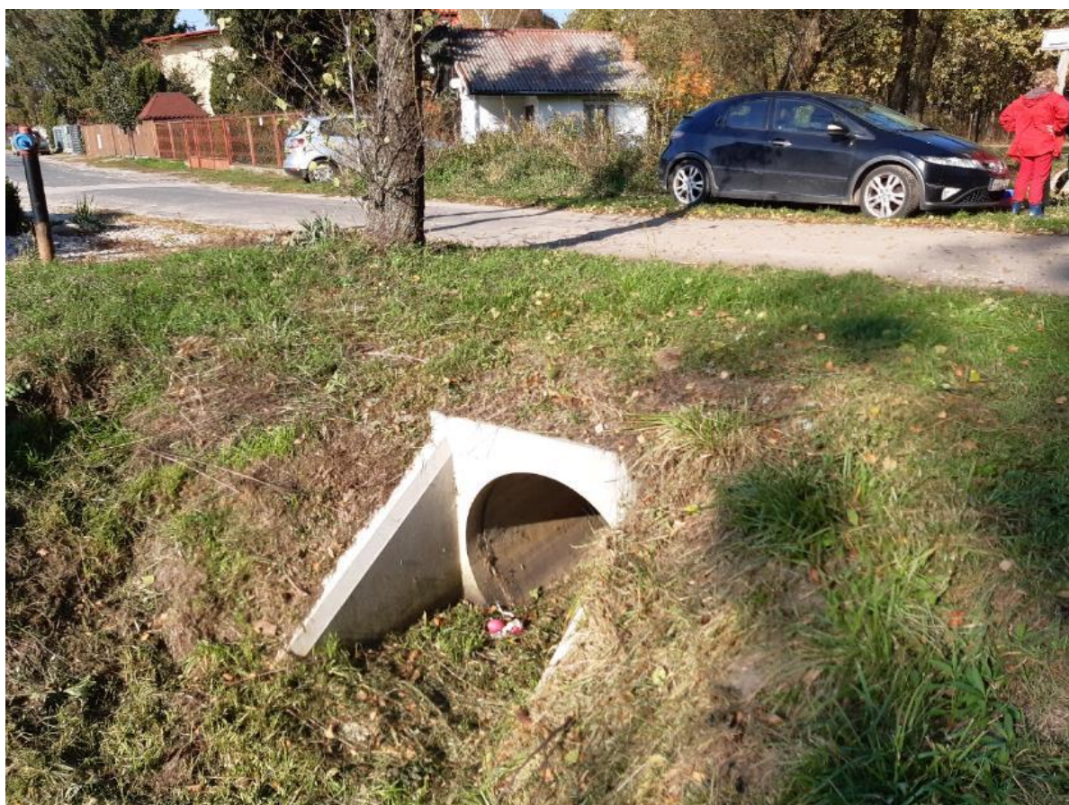
Rycina 109. Przepusty drogowe w rejonie ul. Skibińskiego. Fot. własna
