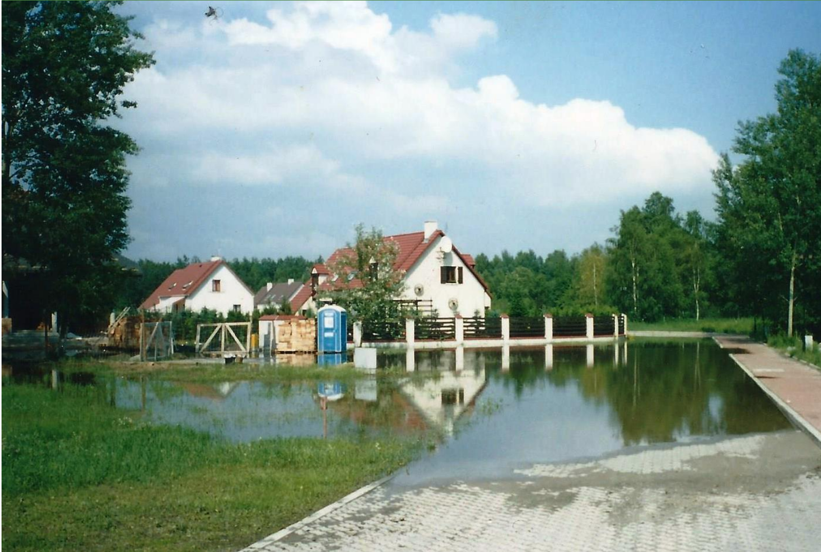
okolice ul. Krótkiej, Izabelin C źródło: ankieta mieszkańca
